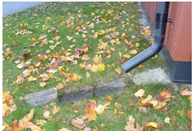
Takdagvatten leds ut på gräsytor via rännalsplattor. Rännalsplattor skyddar husgrunden mot fukt.
