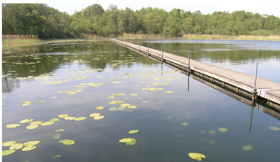
Figur 29. Skärmbassäng i sjön Flaten i Stockholm. I denna anläggning hänger skärmarna under bryggor. Bryggorna fungerar också som promenadstråk.
