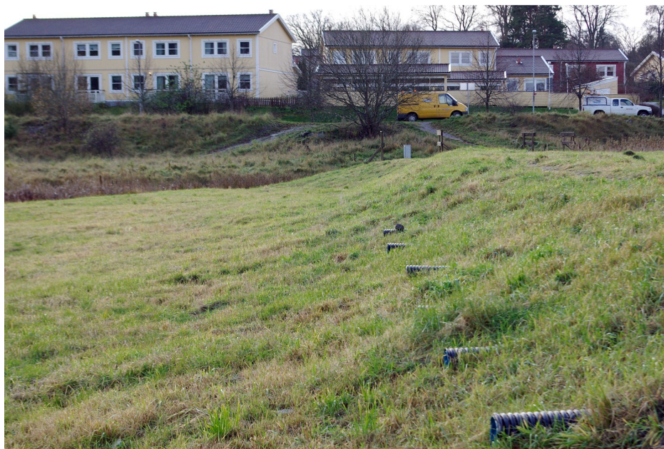
Figur 22. Exempel på en torr översilningsyta för dagvatten vid Viby Gårds dammar.
