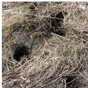
Figur 32. Det höga gräset på dämmningsvallen har fungerat som isolering under vintern. Här har sorkarna trivts och gjort gångar som i värsta fall kan leda till läckage.
