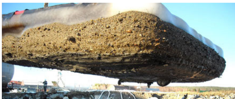
Figur 43. Fryst sediment efter upptag med kran. Foto frigeo.se
