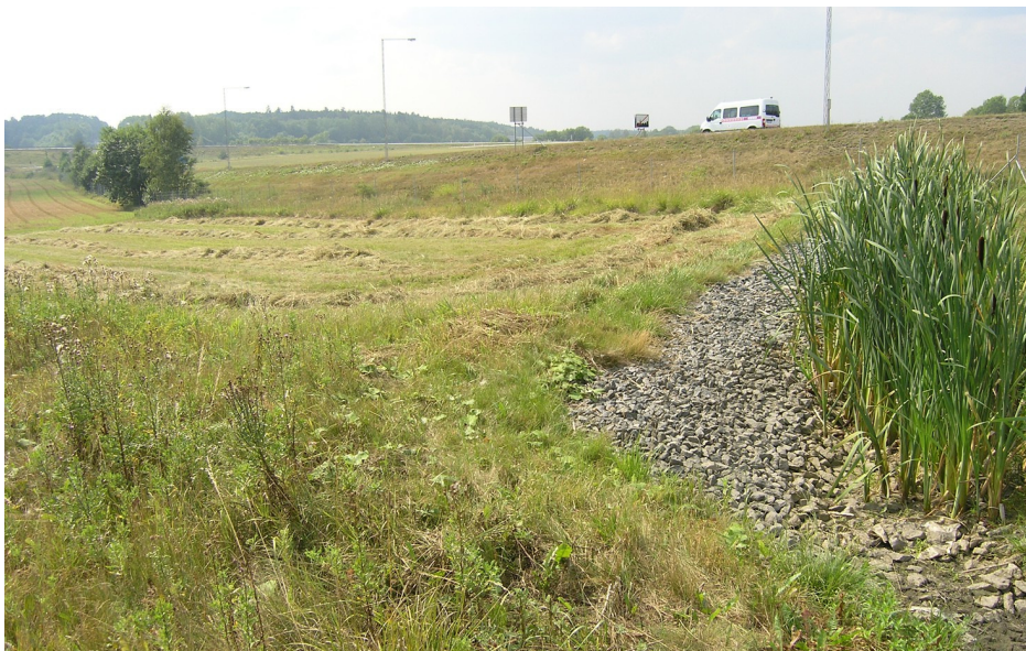
Figur 27. Översilningsyta för dagvatten vid Kvisthamra i Norrtälje. Anläggningen motsvarar en översilningsyta av torr typ, som torkar upp ordentligt mellan beskickningarna. Denna yta har slagits längs med flödesriktningen, vilket är ett alternativ om ytan har god bärighet med liten risk för att det uppstår körspår. Principiellt bör man dock eftersträva att köra tvärs flödesriktningen.
