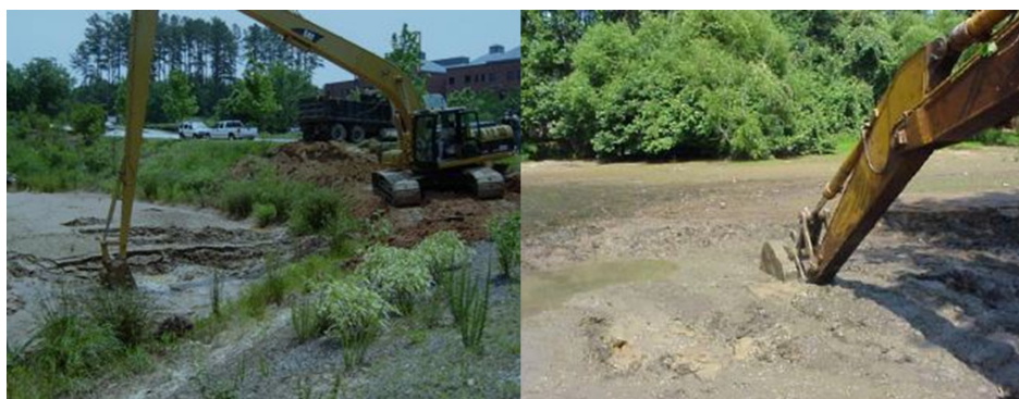
Figur 41. En grävmaskin med lång räckvidd (vänster) och en vanlig grävmaskin (höger) tar upp sediment från en avsänkt dagvattendamm.
