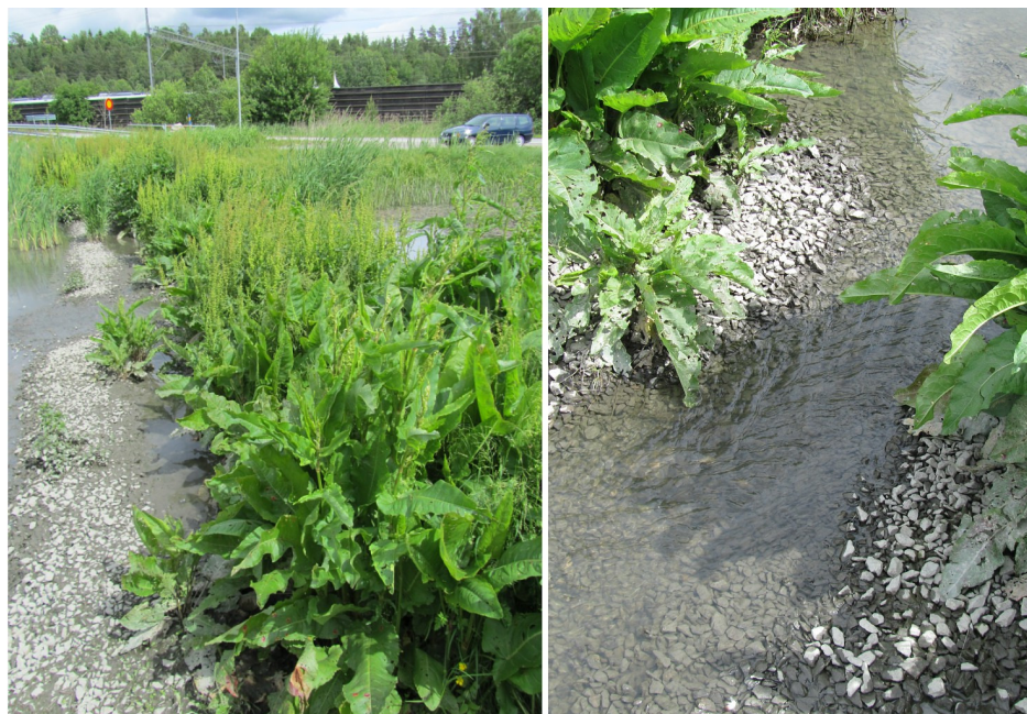
Figur 14. Exempel tröskel av makadam i Ladbrodammen i Upplands Väsby. Tröskeln i detta exempel ska ligga strax under vattenytan, men på grund av att vattennivån i dammen sänkts har en erosionskanal skapats som gör att tröskeln får omvänd effekt – den kanaliserar flödet. Tröskeln behöver lagas med erosionståligt material och vattennivån återställas i dammen.
