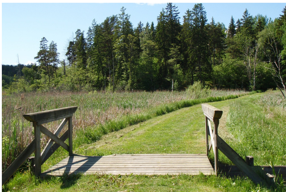
Figur 33. Genom att slå en dammvall flera gånger per säsong så motverkar man etablering av träd och buskar. Förutsättningarna för sork är heller inte så goda.
