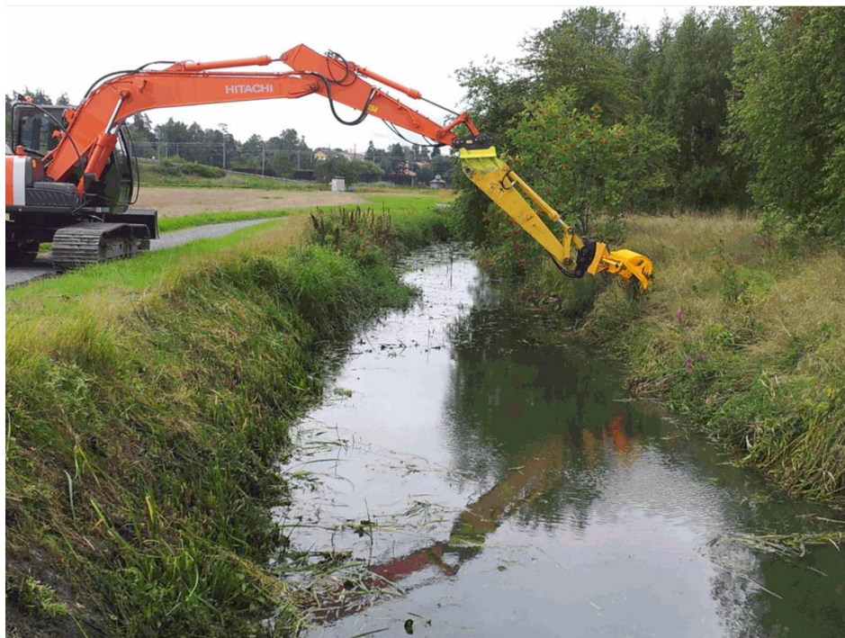
Figur 18. Rensning av dike med klippskopa. Foto Mats Eriksson.
