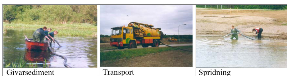
Figur 38. Insamling av så kallat givarsediment genom slamsugning (t.v.), transport (mitten) och spridning i nyanlagd damm (t.h.). Illustration från Ekstam 2004.
