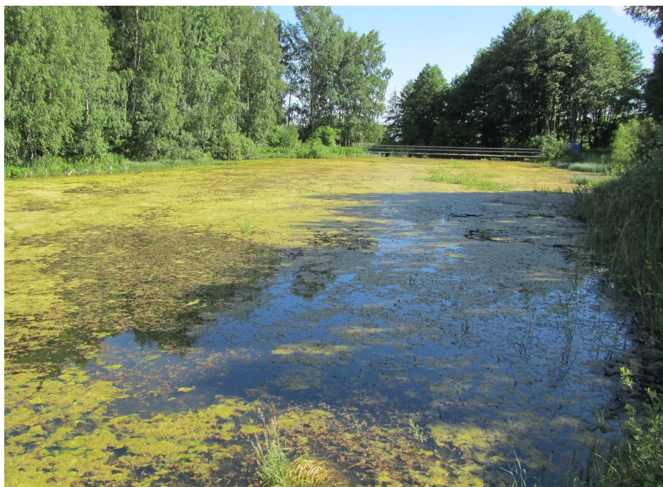
Figur 8. Tibbledammen i Kungsängen är en mycket välfungerande dagvattendamm. En stor del av vattenvolymen upptas sommartid av undervattensväxter som bildar ett levande partikelfilter. På sensommaren finns ett täcke av trådformiga alger på vattenytan, men det är inte så tätt att det skuggar ut undervattensvegetationen. Algerna kan ge ett skräpigt intryck, men innebär antagligen inget problem för reningen. I välfungerande dammar som Tibbledammen bör man vara försiktig med rensning av undervattensvegetation.
