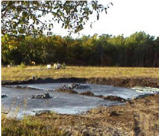
Figur 45. Passiv avvattning av muddermassor bakom en mindre jordvall (Foto Trafikverket).
