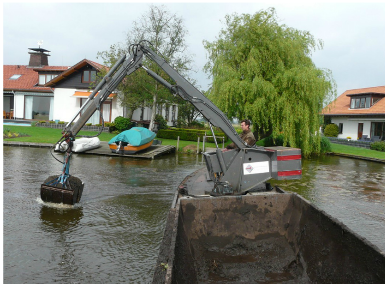
Figur 42. En pontongrävare monterad på en pråm med lastrum för muddringsmassor. Foto baggersite.nl
