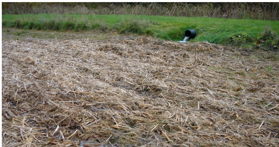
Figur 26. En nyslagen blöt översilningsyta. Ytan har slagits med bandvagn med lågt marktryck tvärs flödesriktningen. Våtmark Alhagen, Nynäshamn.
