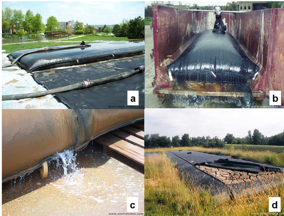
Figur 46. Avvattning av muddermassor med geotextilsäckar: a) fyllning, b) avvattning i container, c) dränagevatten och d) konsoliderade, avvattnade massor. Foto Envirotubes.
