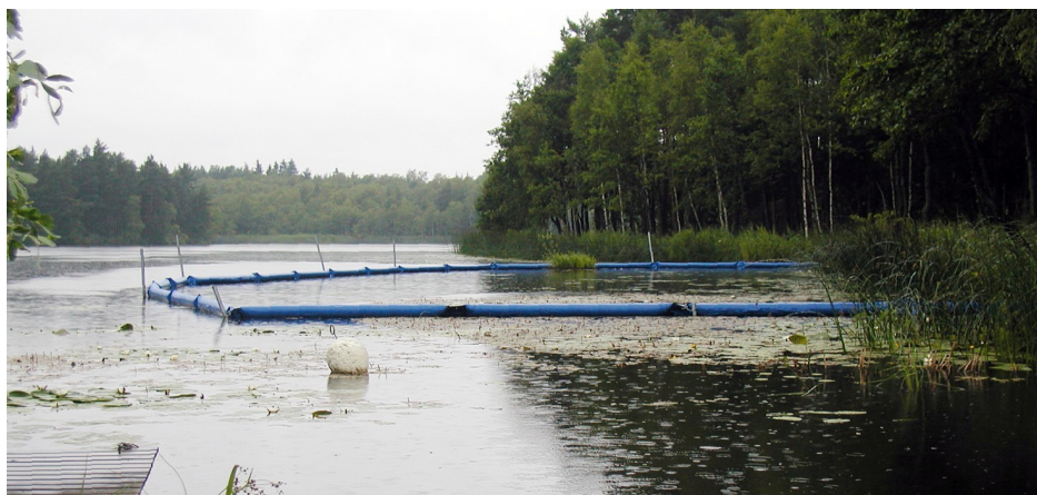
Figur 28. Skärmbassäng i Mörttsjön i Täby. Skärmen hänger på flytkroppar tillverkade av plaströr.
